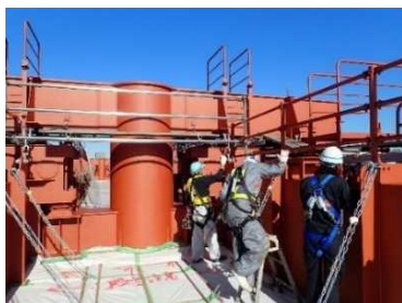
軌道桁・支柱塗り替え作業 （作草部～天台間）
