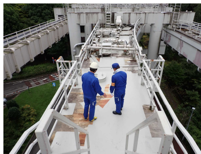
分岐桁通路補修工事巡視
