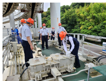
分岐器手回し訓練（車両基地）
