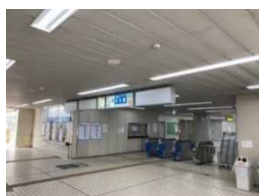
コンコース階照明 作草部駅・みつわ台駅・ 小倉台駅・千城台駅
