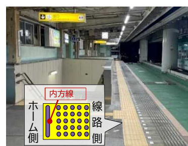
内方線設置工事
