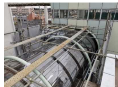
自由通路補修工事 （穴川駅）
