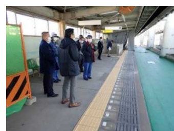
内方線設置工事（千城台駅）
