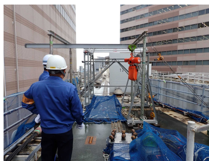
千葉駅12号転てつ機更新工事巡視
