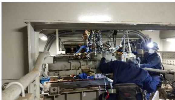
狭小箇所です約1tの機器設置（桁内）
