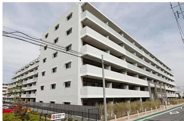
H30.3. サンクレイドル千葉天台竣工
