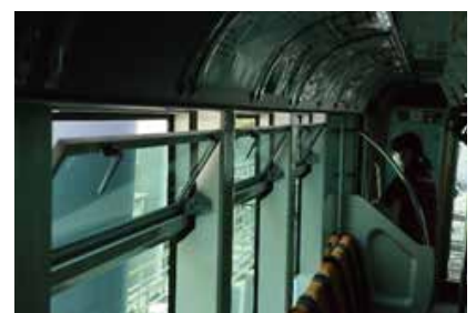
窓上部を常時開放し 換気を行う。
