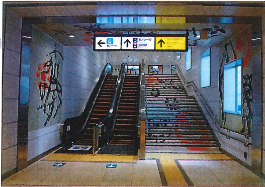
連絡通路内部（手前がJR千葉駅）
