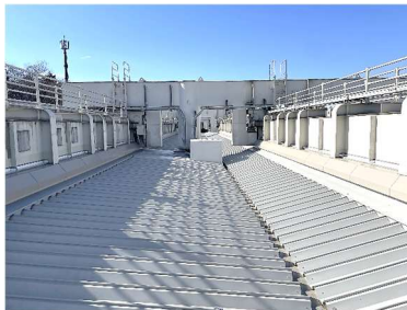
駅舎屋根更新工事 (動物公園駅)
