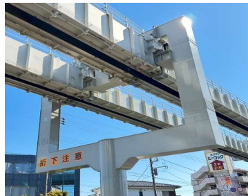
塗替塗装工事 (天台駅～穴川駅間)
