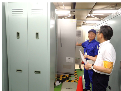
千葉みなと駅ATC/TD地上装置更新工事
