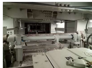
ラインシャフト更新工事 (千葉駅)
