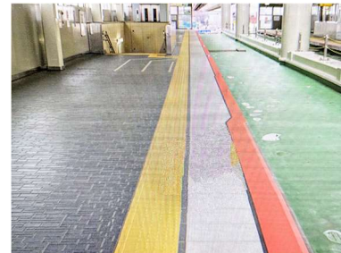
駅舎改修工事 (穴川駅)
