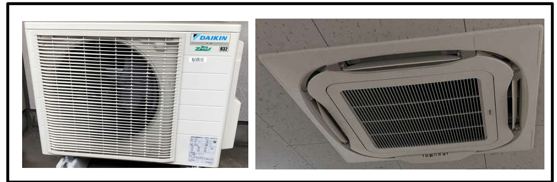
千葉駅(2021(R3)年度施工)
