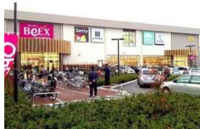
H29.4.27 Skip天台オープン
