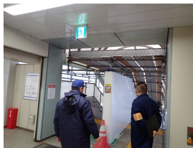
千葉公園駅駅舎改修工事状況確認
