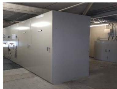
電気室更新工事 (みつわ台駅)
