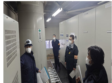
構内施設点検（みつわ台駅）
