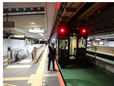
非常走行併結訓練（本線）
