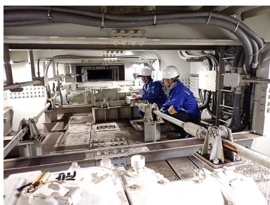
千葉駅12号分岐器更新工事現場確認
