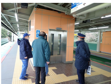
動物公園駅ホーム改修工事状況確認
