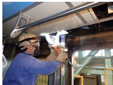
構体検査の様子 (車両基地)
