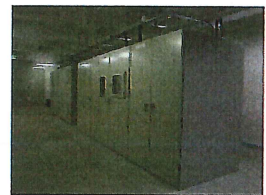
今回導入した回生電力貯蔵装置
