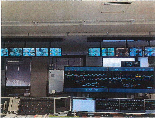
図Ⅲ－5. 中央指令所 ITV装置
