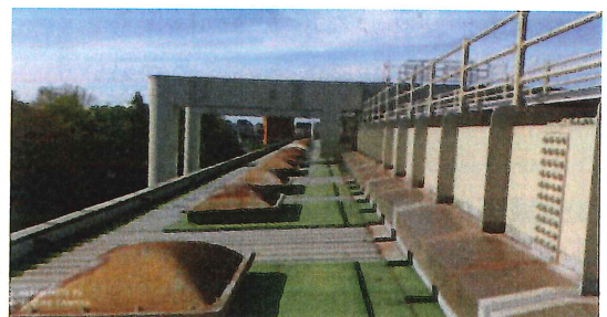
図IV-9. モノレール千葉公園駅舎屋根
