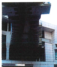
図Ⅲ－４．千葉駅分岐器設備
