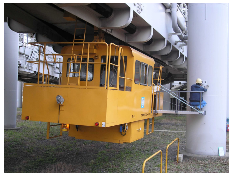
支柱標識点検作業
