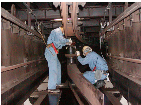
桁内点検作業
