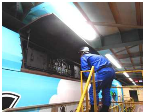
車両点検（屋根上機器）
