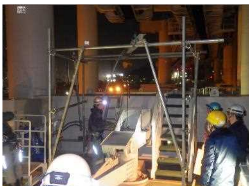
軌道桁・支柱設備点検
