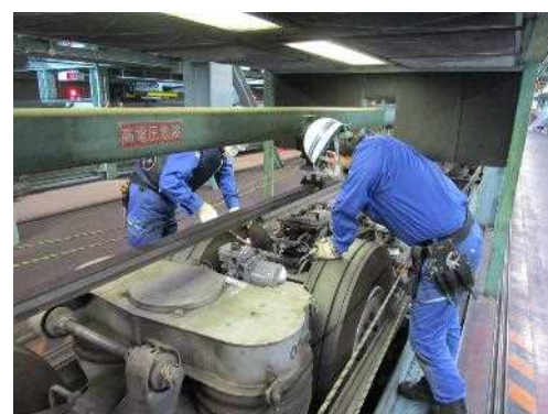
車両屋根上点検（検修庫）
