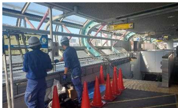
駅舎修繕（市役所前駅）
