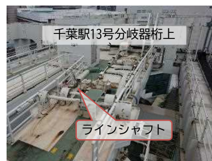
千葉駅分岐器更新工事
