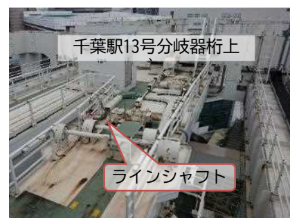
千葉駅分岐器更新工事
