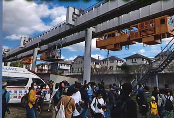
軌道作業車デモ走行
