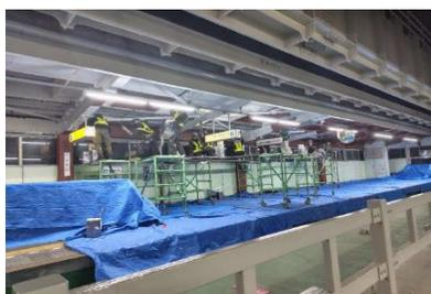
軌道桁・支柱塗り替え作業
