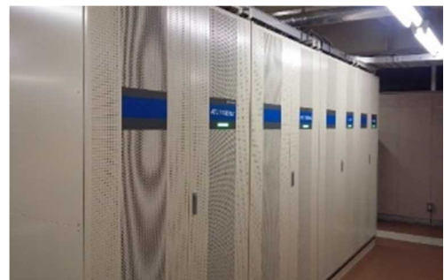
ATC装置更新工事（動物公園駅）
