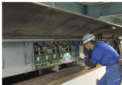
屋根上機器検査（検修庫）
