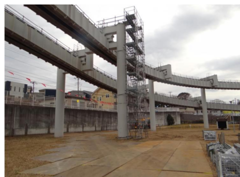
耐震補強工事（車両基地）
