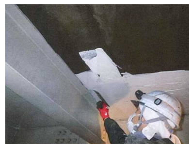
軒天井コンクリート被覆工事
