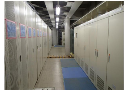
ATC装置更新工事
