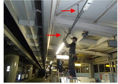
ホーム照明吊り金具更新工事
