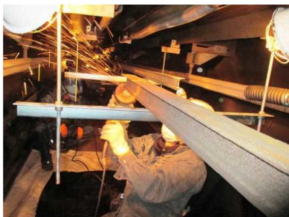
右写真は、桁内電車線の部分取替工事
