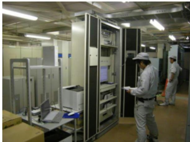
ATC / TD 装置更新接続試験
