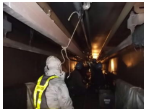
正電車線取替工事（軌道桁内）
