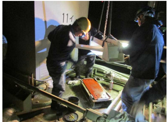
分岐器交換工事
