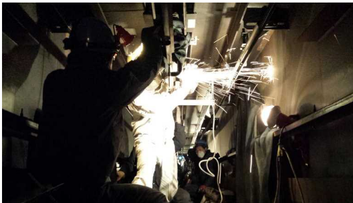
正電車線の取替工事
