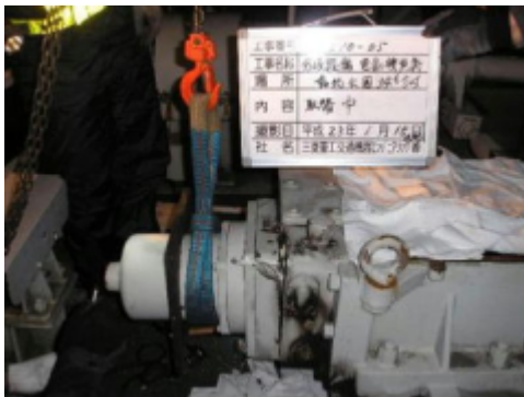
分岐器(電動機)交換工事
