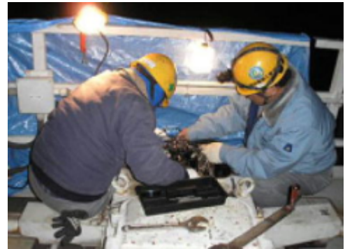
分岐器(転てつ器)交換工事
