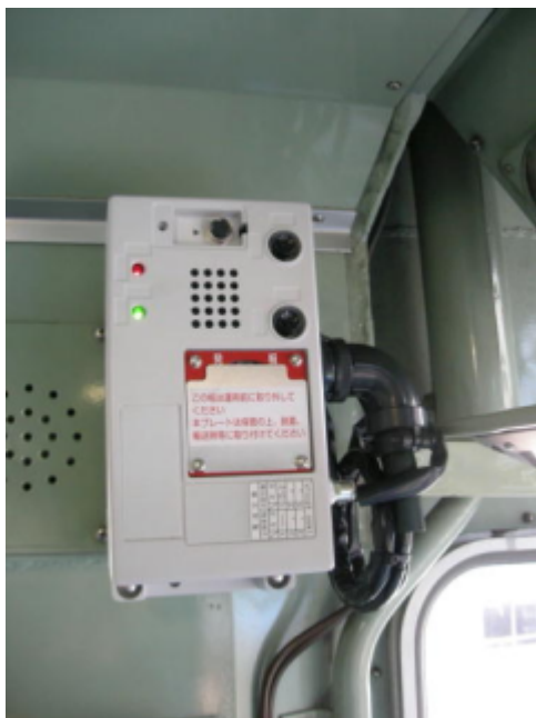
防護無線装置改造 (電源二重化・デジタル化)
