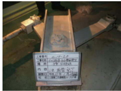
分岐器(L型鋼)交換工事
