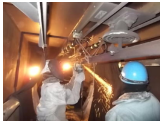
正電車線の取替工事
